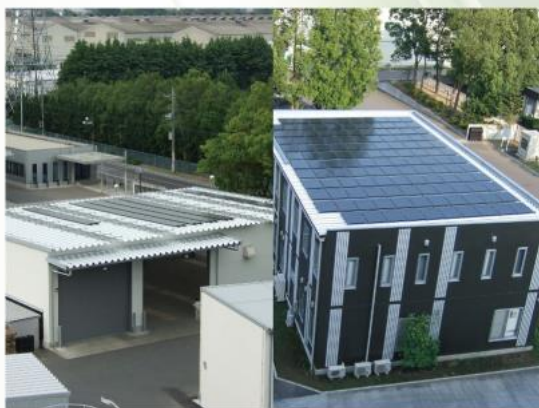
群桐エコロ(株)に設置されたソーラーパネル。群桐グループは、今後も太陽光発電の増設を計画しています。
