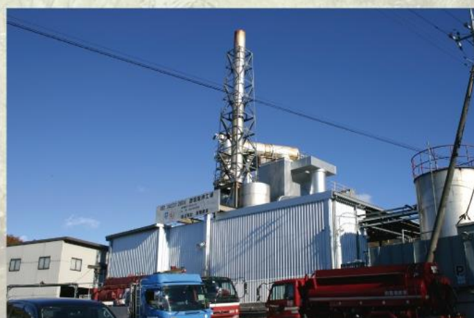
プラント外観(敷地面積 6,000㎡)
