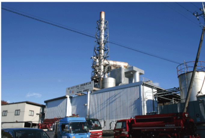
プラント外観(敷地面積 6,000㎡)
