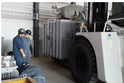
大型フォークリフトで特高トランスを移送する際の注意すべきポイントを指導する様子。
