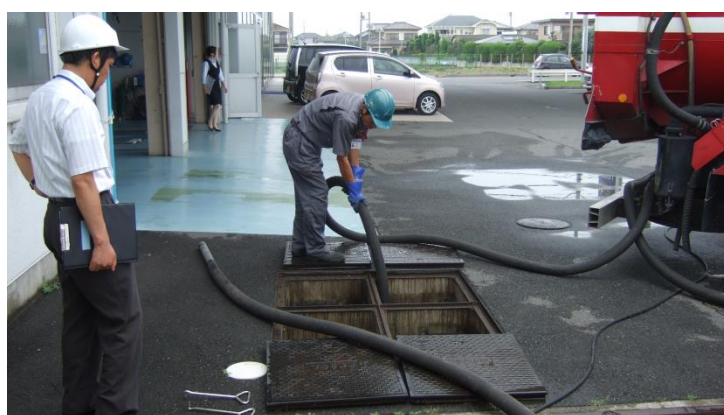
作業立会審査（汚泥回収）
