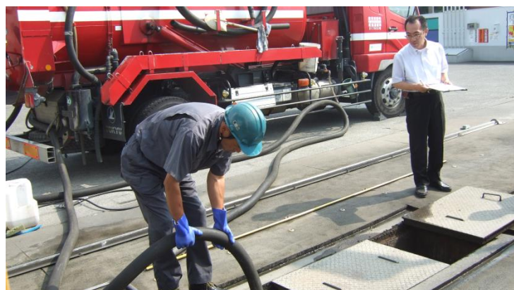
作業立会審査（分離層清掃）
