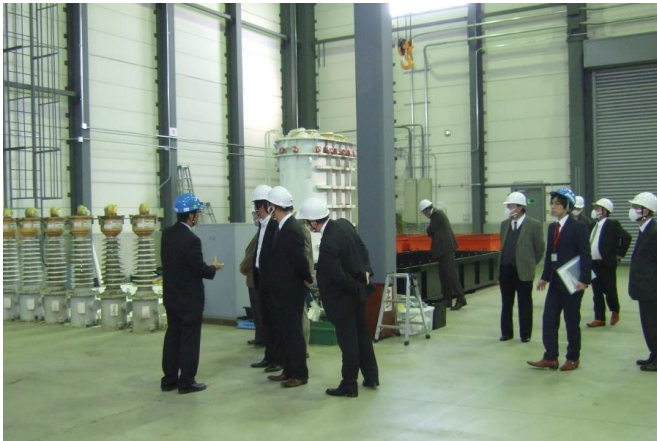
低濃度 PCB 廃棄物受入保管施設の見学
