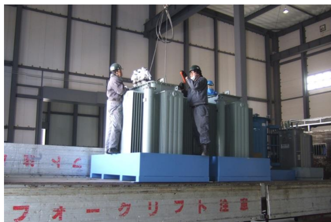
トランス荷卸し①
