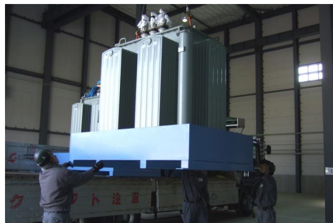
トランス荷卸し②
