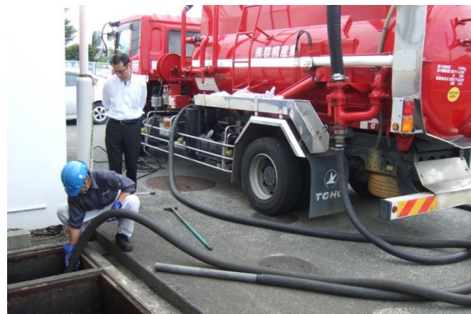
(株)群桐産業 作業立会審査（分離槽清掃）
