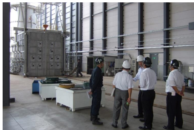
群桐エコロ(株) 固定床炉審査
