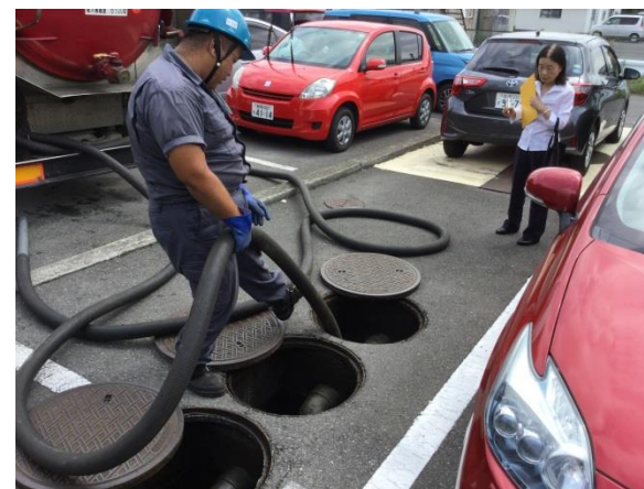
(株)群桐産業 作業立会審査（分離槽清掃）
